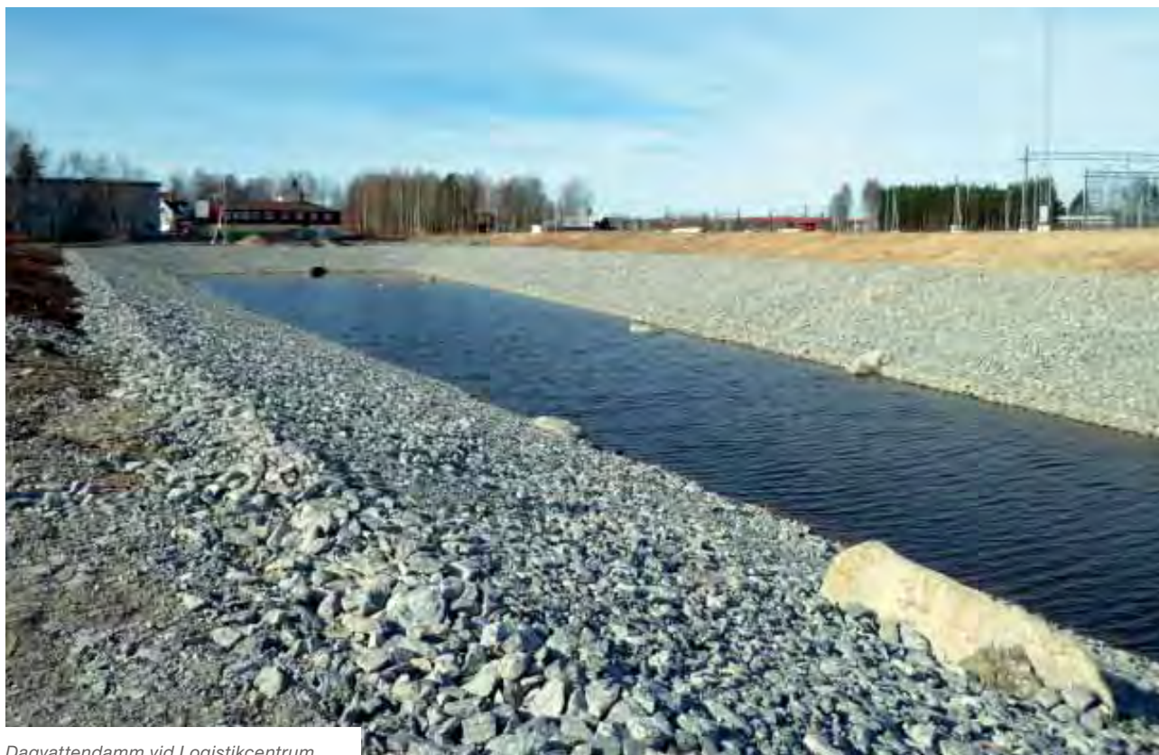
Dagvattendamm vid Logistikcentrum.
