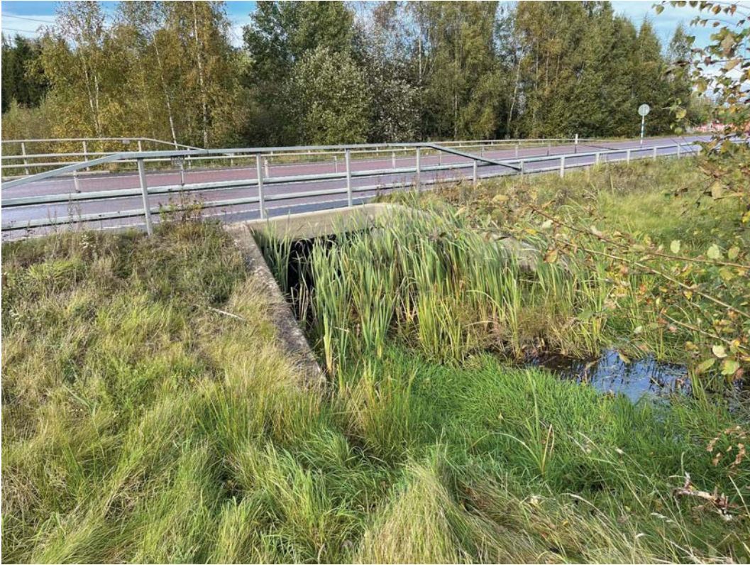
Lasstorpsdiket uppströms väg 52 i norra delen av inventeringsområdet.
