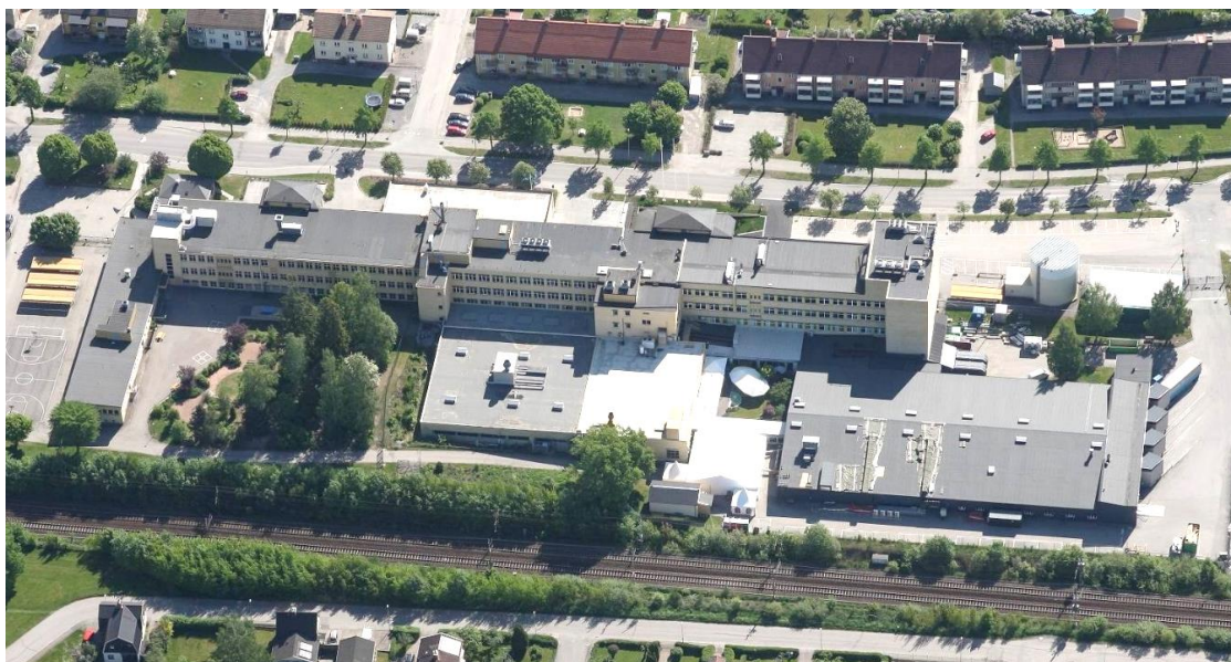
Figur 2. Snedbild över byggnadskomplex.
