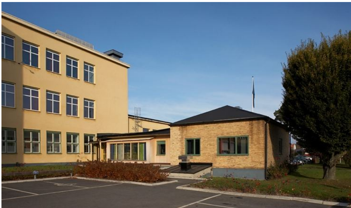
Figur 7. Baksidan av Kunskapsskolans entré.
