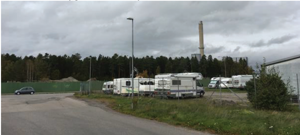
Industribebyggelse och kraftvärmeverkets skorsten, Katrineholms kommun, 2019
