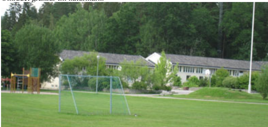
Skolbyggnaden med lekplats
