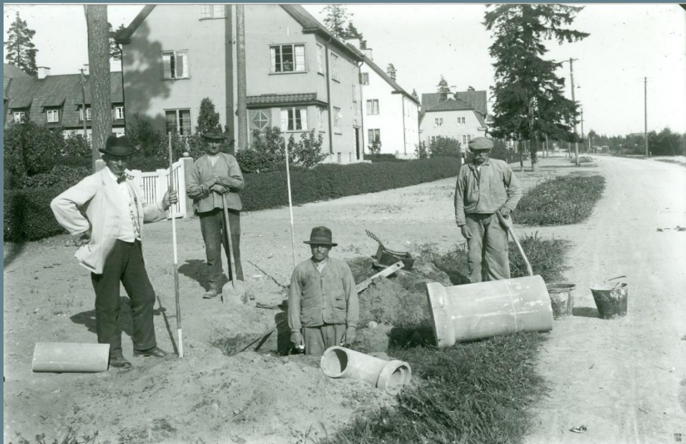
Rörläggning på Oppundavägen år 1924, källa kommunarkivet.
