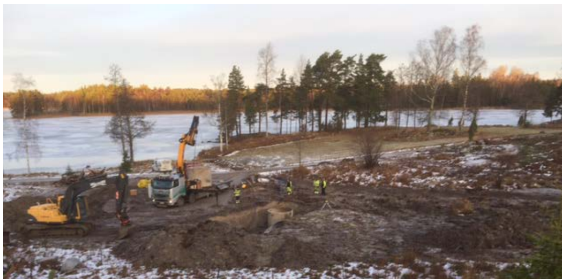
Slutförandet av va-anläggning i områdets västra del under vintern 2016-2017
