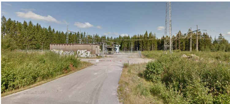
Transformatorstationen i södra delen (Källa: GoogleMaps)
