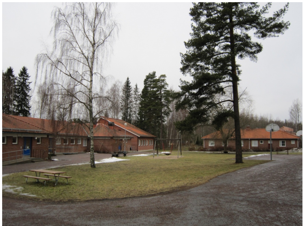
"Tallheden" är byggnaden till höger, "Stenkullen" är buset till vänster. Stenkullen ligger utanför planområdet.
