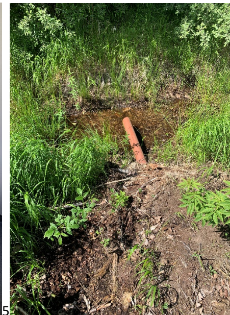
1 inrett sovrums, 2 förbränningstolett med rinnande vatten i handfat, 3 inrett sovrums, 4 vattentolett, 5 vatten i handfat, 6 gråvatten går ut i dike vid huset
