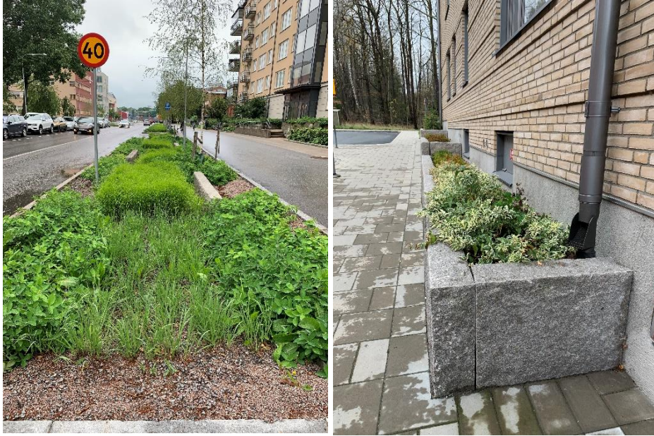
Figur 4. Exempelbild på nedsänkt växtbädd intill väg samt upphöjd växtbädd intill fasad (foto Bjerking).
