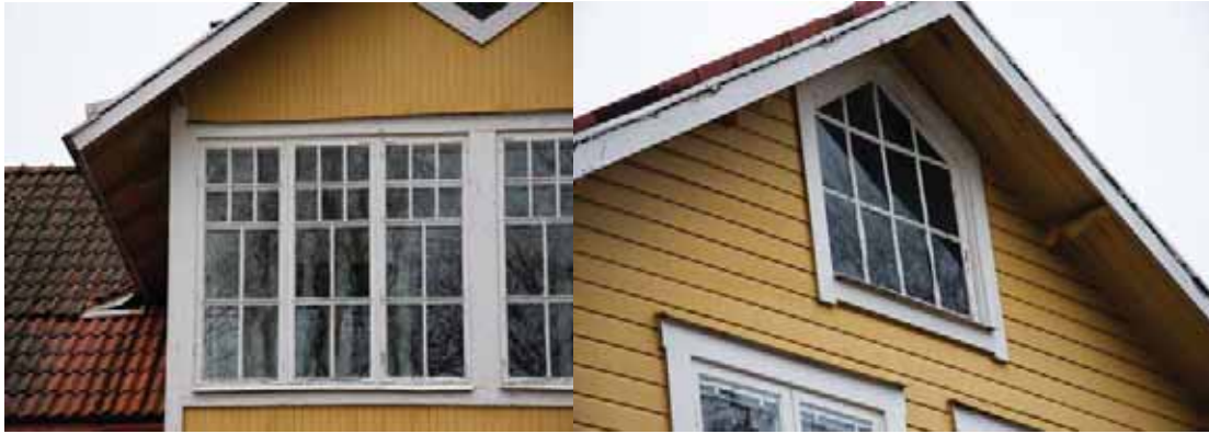
Stående pärlspont och fönster på verandadelen
