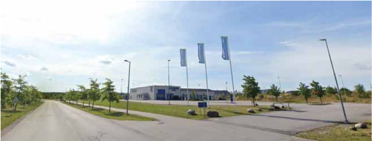
Befintlig verksamhet vid Österleden strax sydväst om planområdet (Google maps, augusti 2019).
