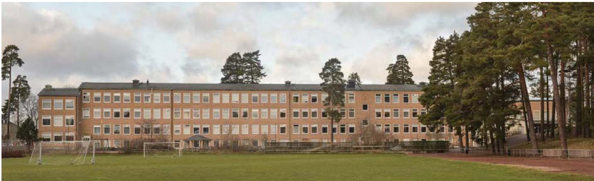
Tallåsskolans östra fasad med sin karaktäristiska täta fönstersättning och långsmala planform.
