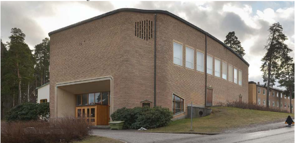
Tallåsskolans aula sedd från norr.
