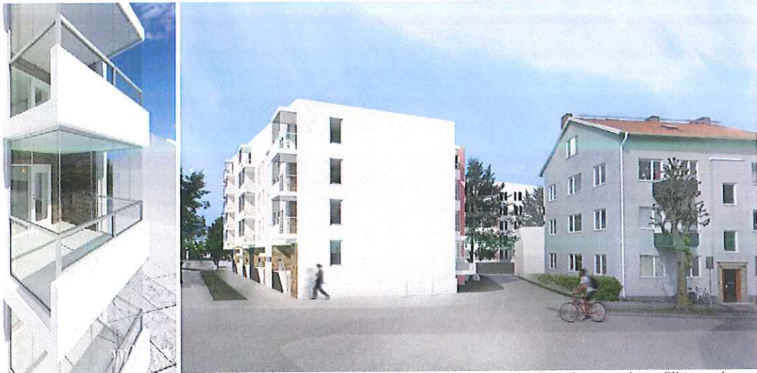
Till vänster: Illustration, balkonginglasning med profilösa element. Till höger: Mötet mellan ny och gammal bebyggelse i kvarterets sydvästra del. Bilder: White arkitekter
