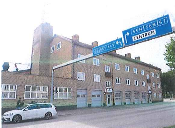
Brandstationen sedd från Djulögatan
