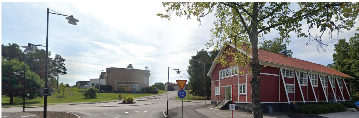
Figur 9: Aulabyggnaden i fonden och gymnastikbyggnaden till höger, sett från Drottninggatan åt söder.
