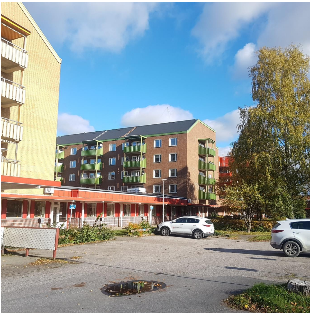
Figur 11: Befintlig bebyggelse inom planområdet. Bilden tagen från Drottninggatan
