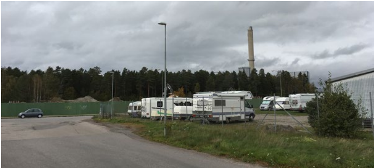
Industribebyggelse och kraftvärmeverkets skorsten, Katrineholms kommun, 2019
